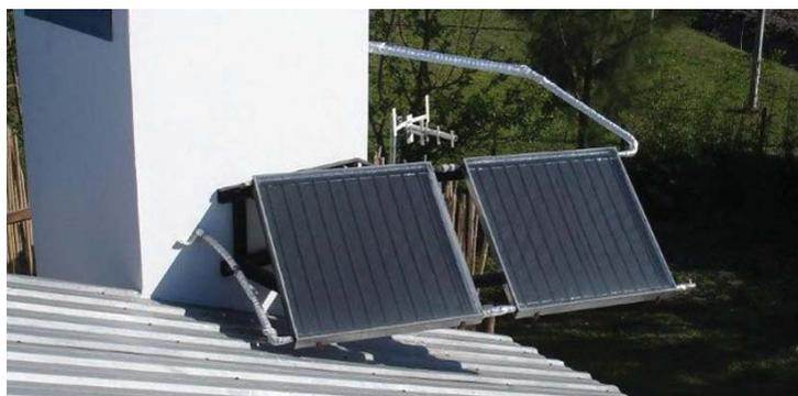
▲ Los caños de conexión son de polipropileno aislado térmicamente y de los rayos UV.
